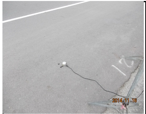
海豐橋(振動監測情形)
