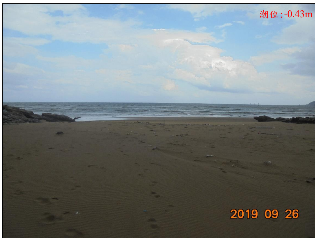
圖 4-12a 監測區南側大岩礁（黑石仔）後方碇堡（2019/09/26）
