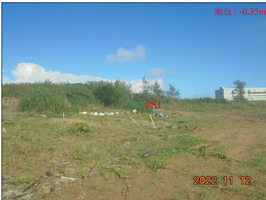
附圖 2-4 監測區北側輔助觀測樁位置(2022/11/12)
