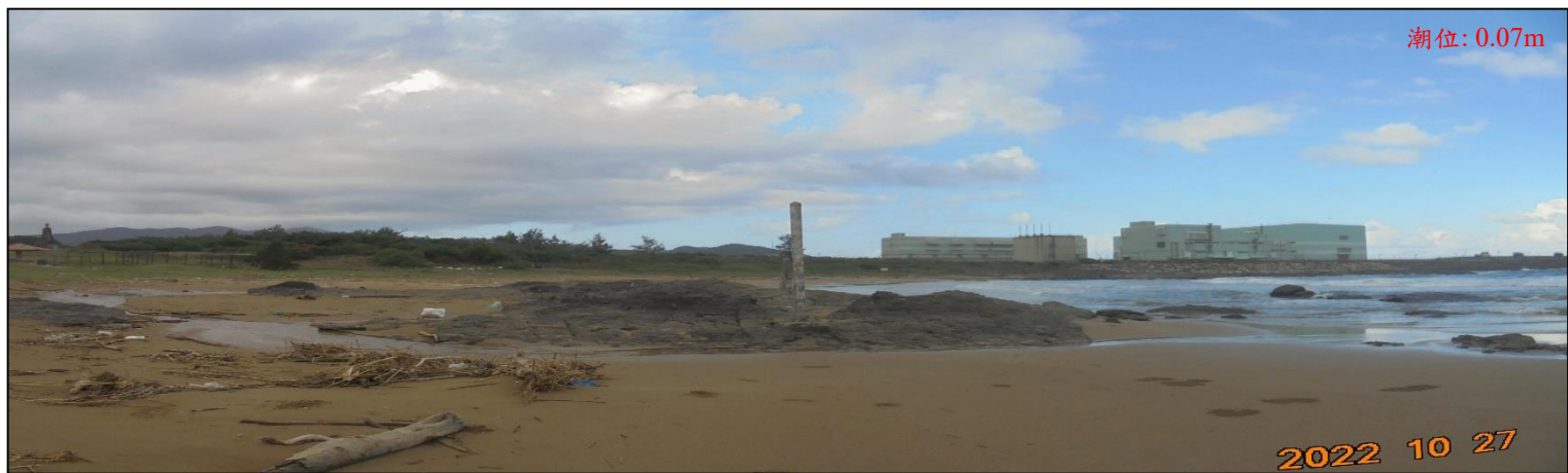
圖 4-9(a) 監測區北側礁石區內#S2 樁附近地形 (2022/10/27)
