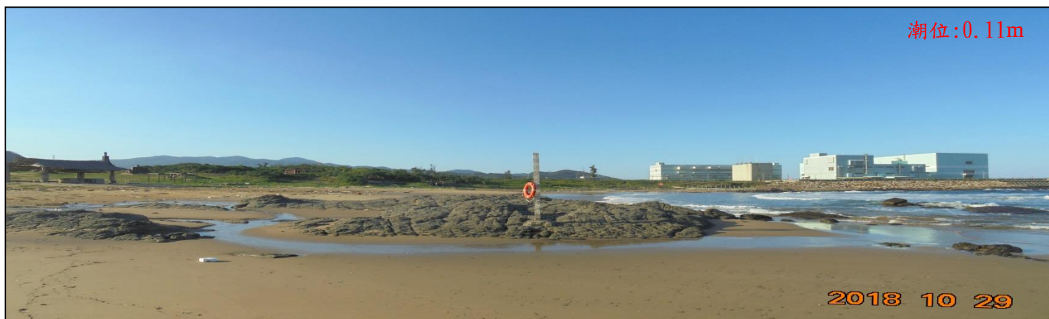
圖 4-4b 監測區北側礁石區內#S2 樁附近地形 (2018/10/29)
