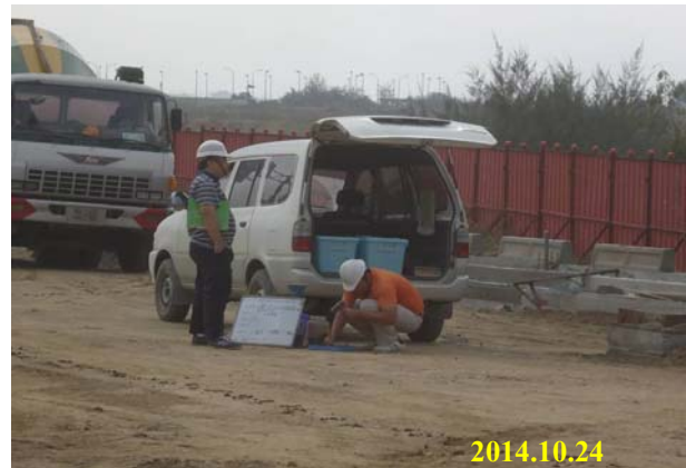
照片 1.1-6 鹿港區第二聯絡道路工程 (C10002) 道路碎石級配底層工地密度取樣送驗
