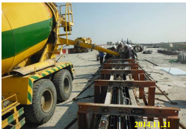
照片 1.1-5 鹿港區第二聯絡道路工程 (C10002)) 橋面中央分隔島混凝土澆置
