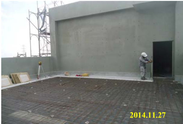
照片 1.1-1 線西區服務中心大樓工程(A10008) 頂防水隔熱層混凝土澆置前之洩水坡度高程放樣
