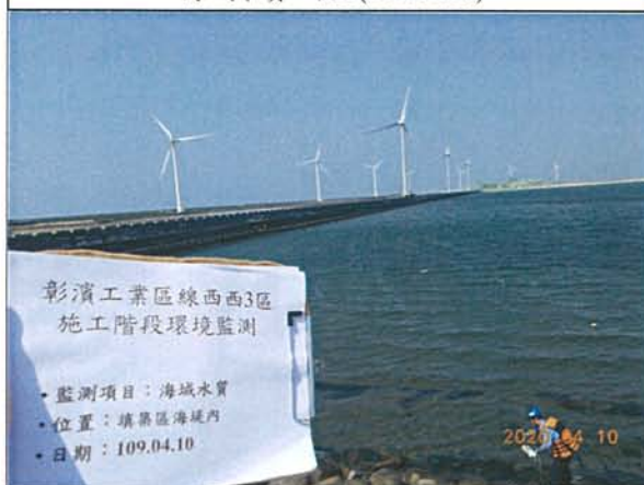
海域水質：填築作業區海堤內(109.04.10)
