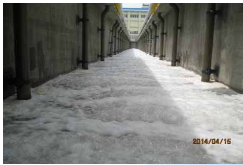
補水1米進行鼓風測試情形良好
