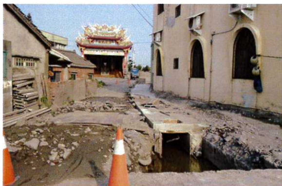
圖 1.11a 許厝站道路施工狀況
