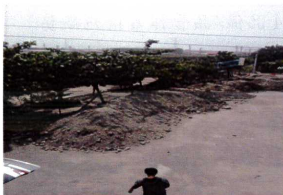
圖 1.11b 許厝站周遭土方堆置狀況
