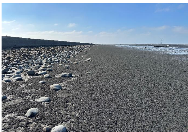
照片 1.3-22 螞蛄蝦福寶漁港測站
