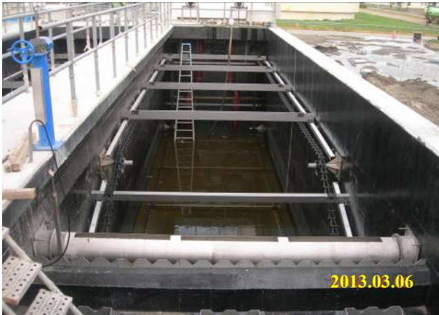
照片 1.1-1 線西區廢水處理場第二期擴建工程 (A9802) 三沉池矩型刮泥機組裝
