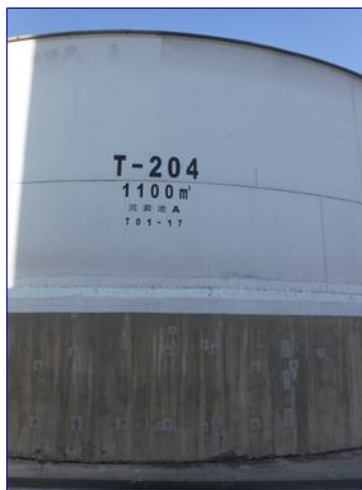
桶槽與基座間鋪設 FRP不滲漏材
