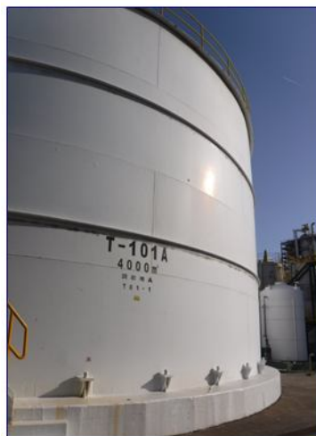
廢水槽與基座間披覆 FRP防滲漏材
