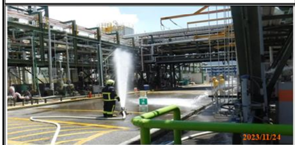
說明：滅火班_架設消防灑水設施
