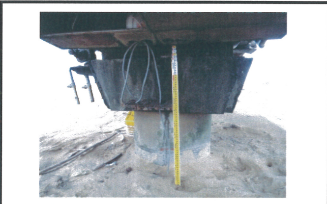
海岸地形沙灘定位樁調查情形 (101/3/7)
