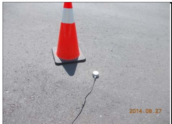
台西海口橋(振動監測情形)
