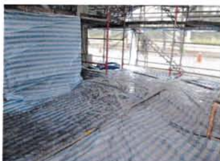
管架下方鋪設不透水塑膠帆布收集漆屑
