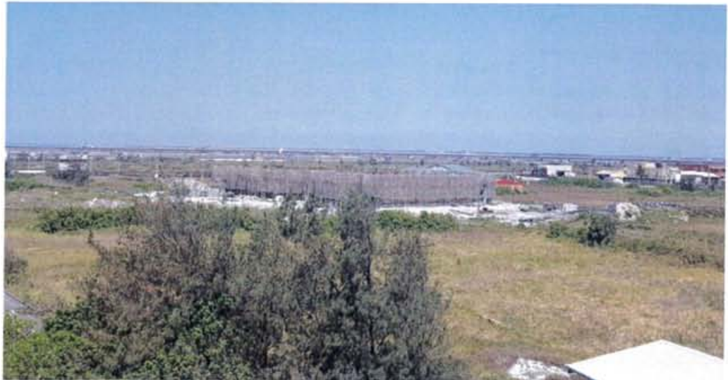
圖二：台西站西北方武當北極殿興建工程
