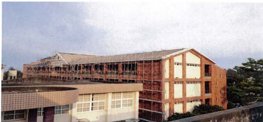
圖三：參寮站東北方教室整修工程
