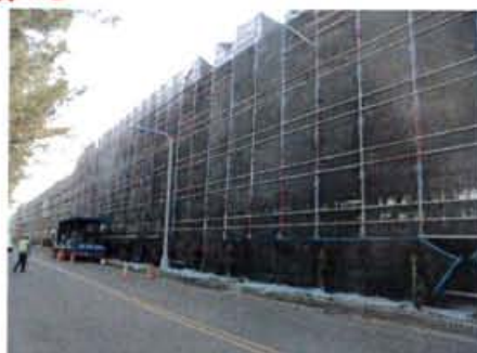
管架外圍四周架設防塵網防止漆屑飄落管架外
