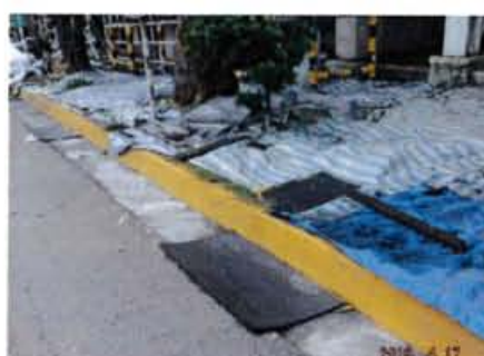
排水溝蓋鋪設橡膠墊避免漆屑流入排水溝
