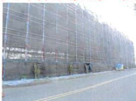
管架外圍四周架設防塵網防止漆屑飄落管架外
