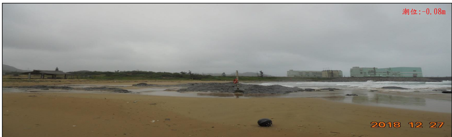
圖 4-9a 監測區北側礁石區內#S2 樁附近地形 (2018/12/27)
