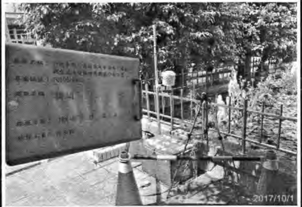
↓說明：橋頭—廠區周界外噪音·振動監測
