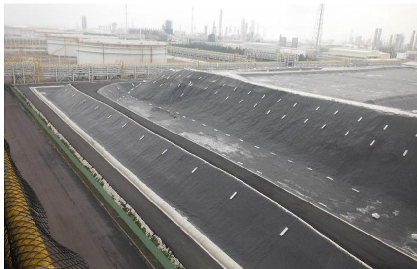
鋪設不透水布(HDPE)1mm厚度，並以熱熔接合及螺絲固定
