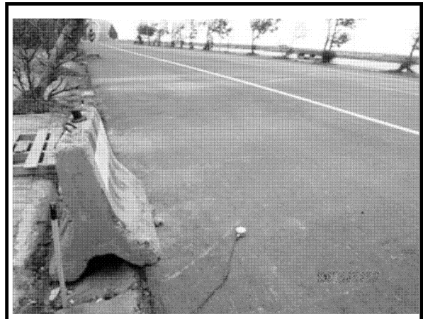
五條港出入管制站(振動監測情形)
