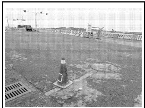
台西海口橋(振動監測情形)
