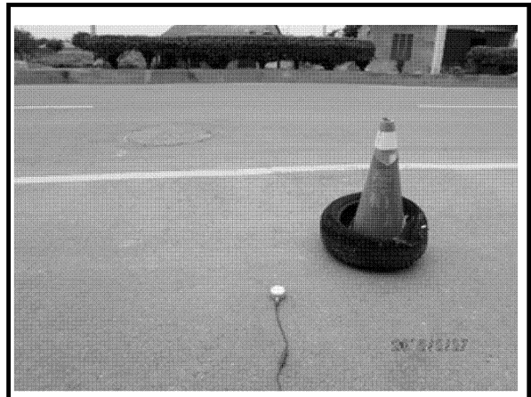
海豐橋(振動監測情形)
