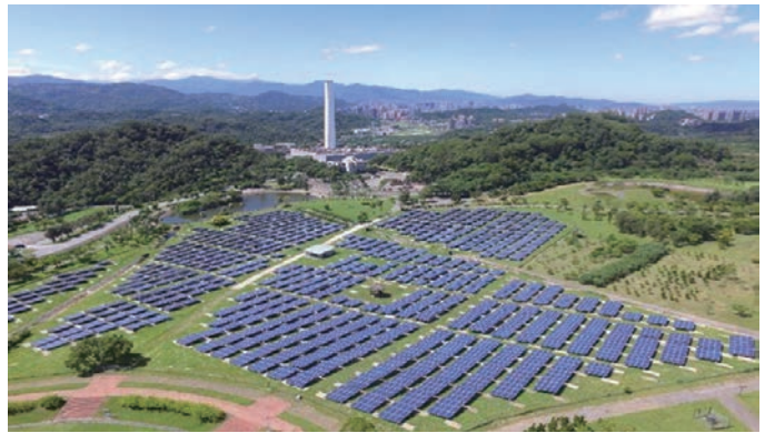
「臺北能源之丘」掩埋場太陽能電廠。
