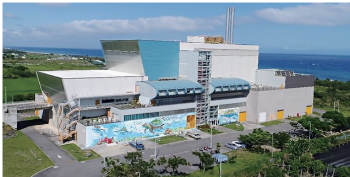
臺東縣垃圾焚化廠於 112 年正式啟用。
