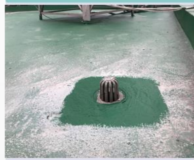
屋頂漏水改善防水施 做中
