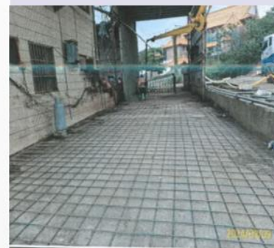
備勤室前地板修繕中
