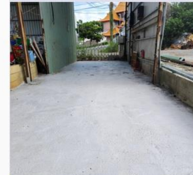
地板修繕完成
