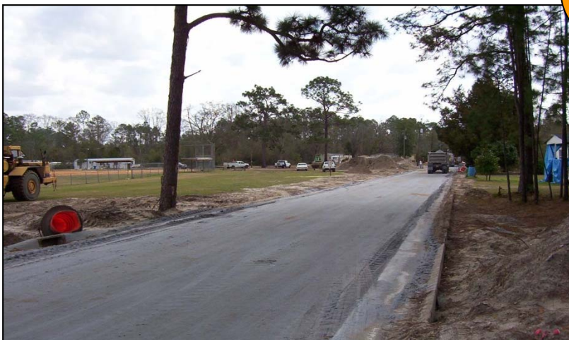
使用副產石灰施工完成狀況
