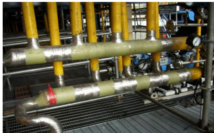
鍋爐改善(新增甲烷氣集管)
