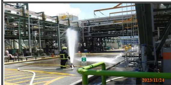
說明：滅火班_架設消防灑水設施
