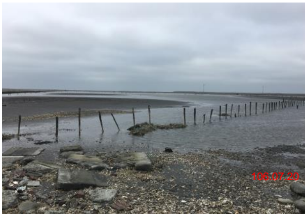
照片 1.3-22 螞蛄蝦福寶漁港測站
