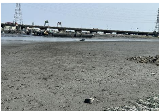
照片 1.3-28 螞蛄蝦吉安水道測站
