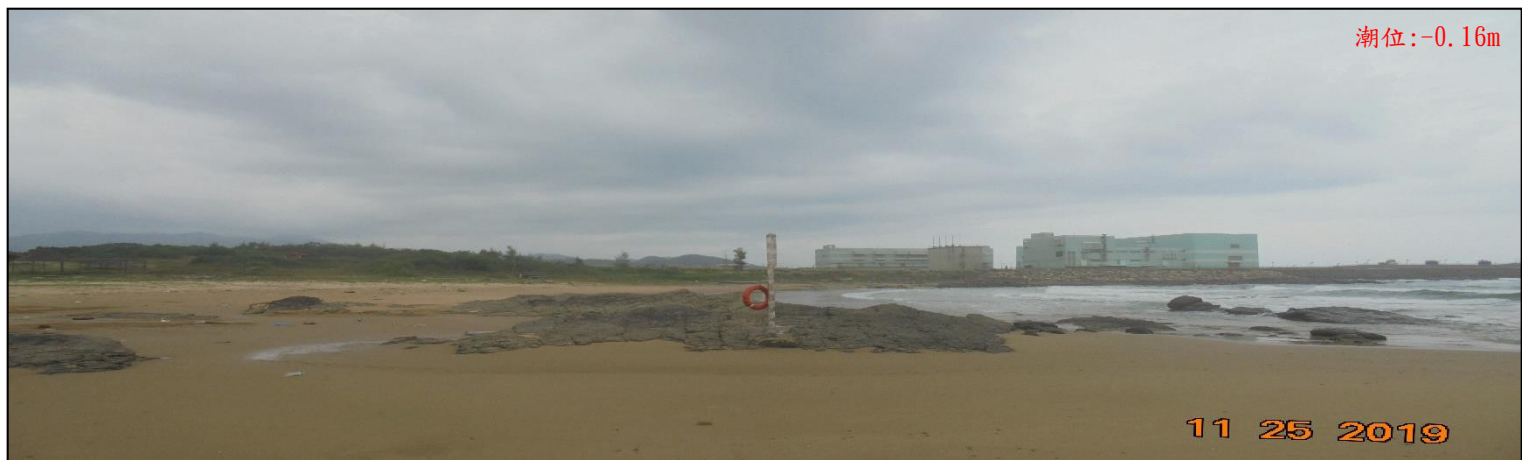
圖 4-9a 監測區北側礁石區內#S2 樁附近地形 (2019/11/25)
