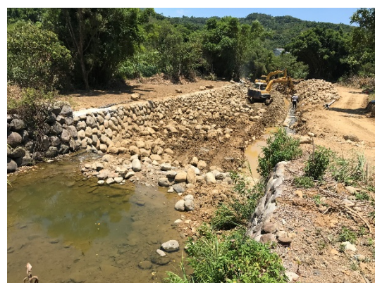
上游水文站上游河道施工情形
