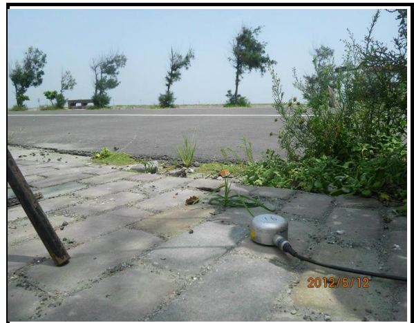
五條港出入管制站(振動監測情形)
