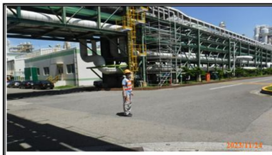
說明：避難引導班_事故地點路口人車管制
