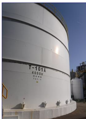
廢水槽與基座間披覆 FRP防滲漏材
