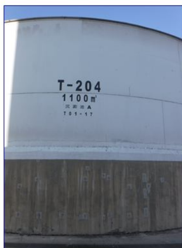
桶槽與基座間鋪設 FRP不滲漏材
