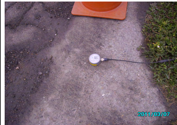
五條港出入管制站(振動監測情形)
