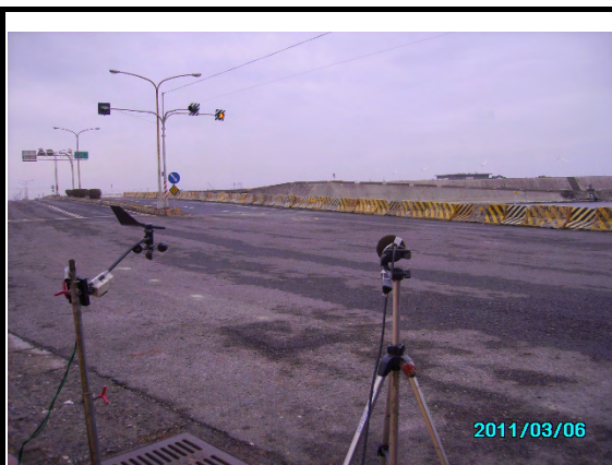
台西海口橋(噪音監測情形)
