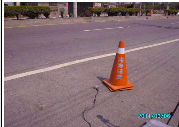
海豐橋(振動監測情形)
