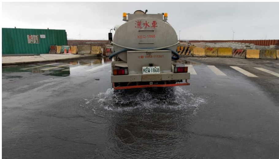
圖 3 工地執行粒狀污染物抑制及揚塵防制工作
