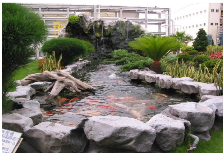
南亞麥寮廢水處理場放流池
