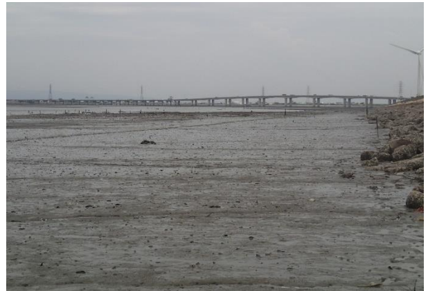
照片 1.3-29 螞蛄蝦崙尾水道測站
