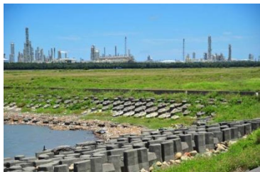
圖64、海豐樣區新虎尾溪 出海口北岸填砂造
