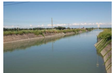
圖71、三條崙樣區中的引 水道 (102.06.08)。
