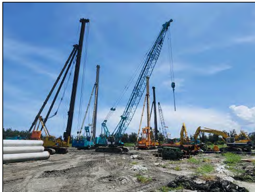
儲槽基樁打樁中
