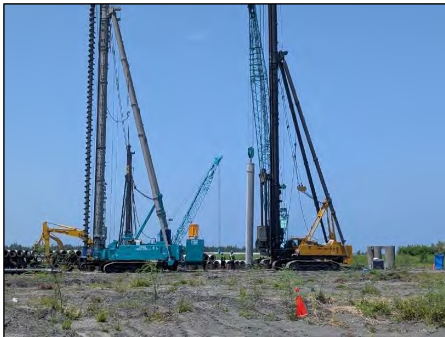
打樁機現場組裝作業
