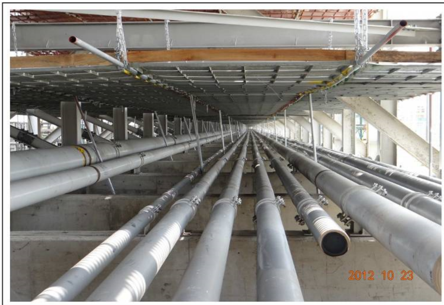
在麥察區 2.7 路 C1 段管架《根頂/集順》在新建管墩上進行配管作業情形。(一) (101.10.23 由西往東拍攝)
