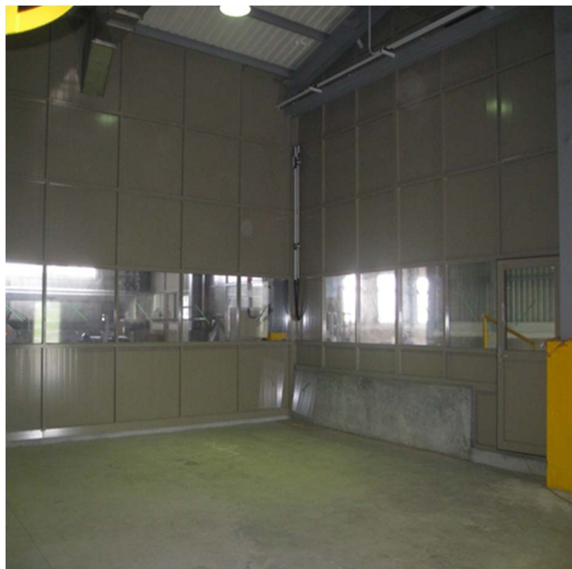
廚餘前處理區鋁製隔間
