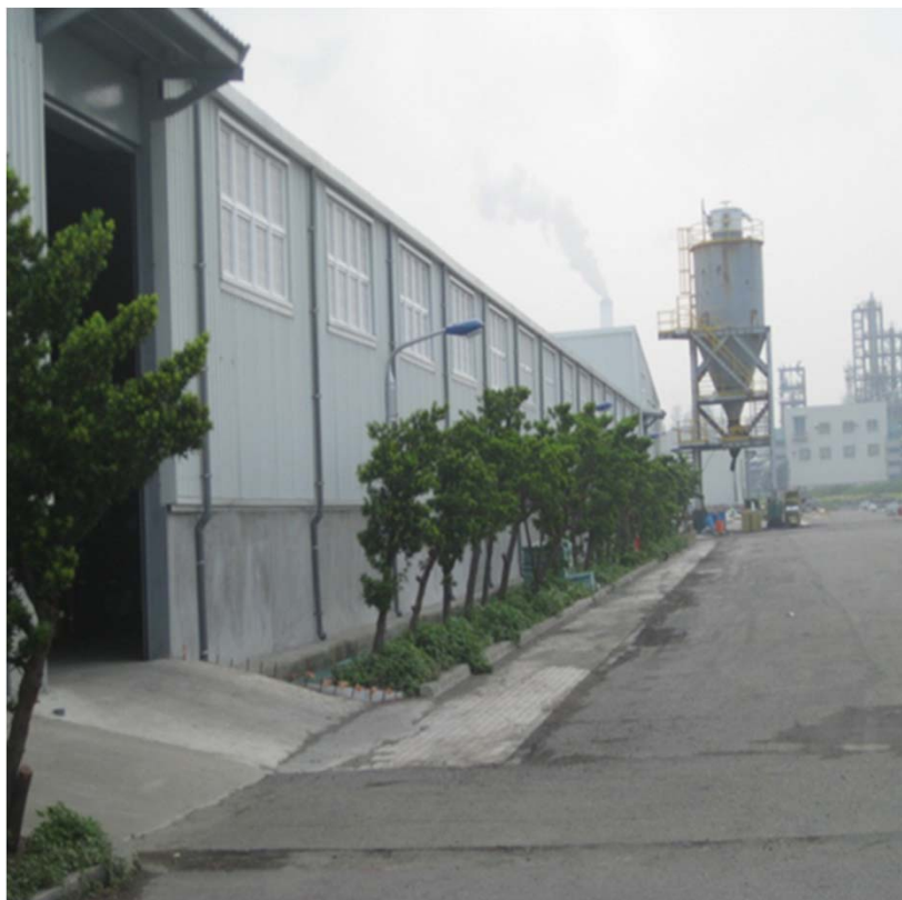
廚餘堆肥場廠房外觀
