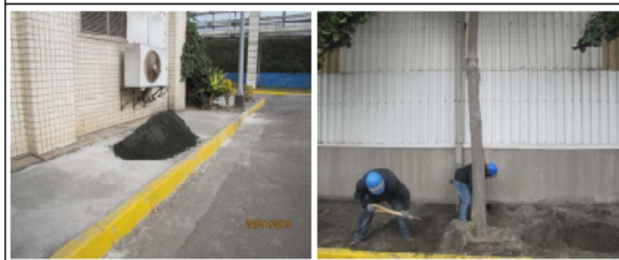
辦公室南側現場回填情形
