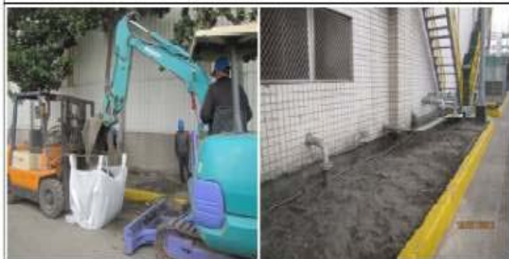
辦公室南側現場開挖情形
