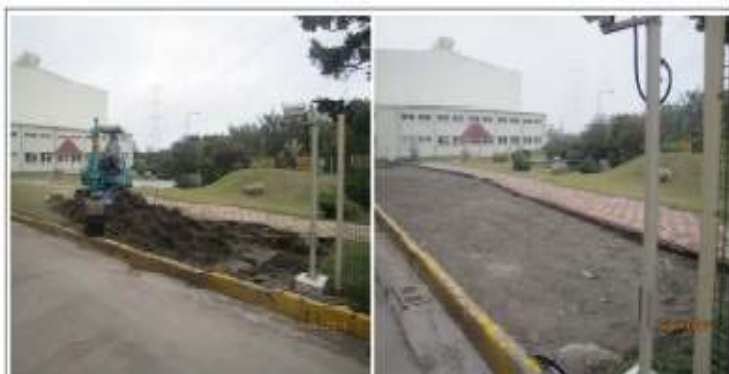
環保公園現場開挖情形
