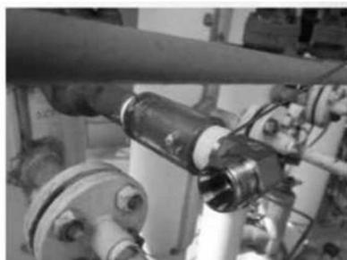
90度Tube接頭安裝時，須一次加鎖到位，不可為配合配管退牙安裝，須拆掉重新安裝。
