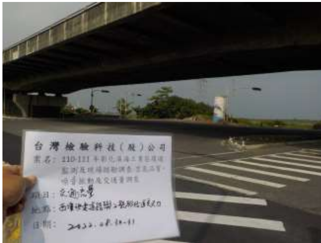
照片 1.3-7 噪音振動交通量測站 1 【西濱快速道路與 2 號連絡道】
