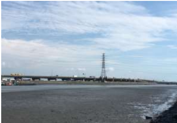
照片 1.3-28 螞蛄蝦吉安水道測站
