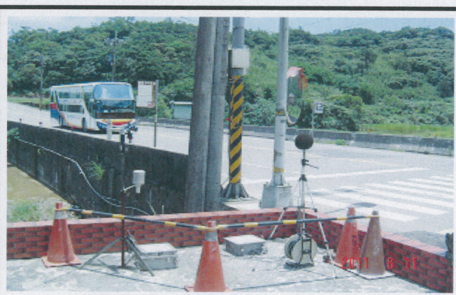
噪音振動監測情形 (100/6/11)
