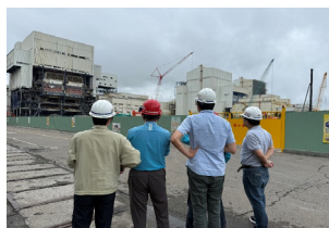
公用廠拆除機組現勘
