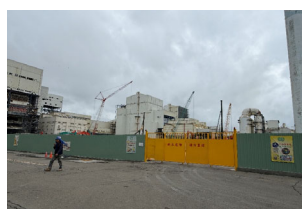
公用廠拆除機組現況
