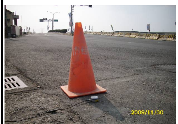
台西海口橋(振動監測情形)
