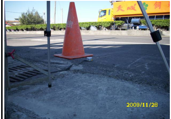
海豐橋(振動監測情形)
