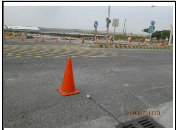
台西海口橋(振動監測情形)
