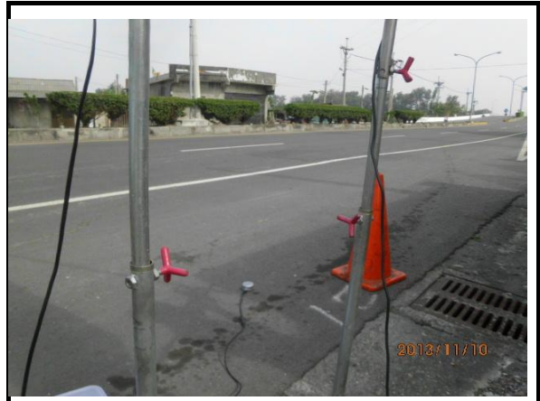
海豐橋(振動監測情形)
