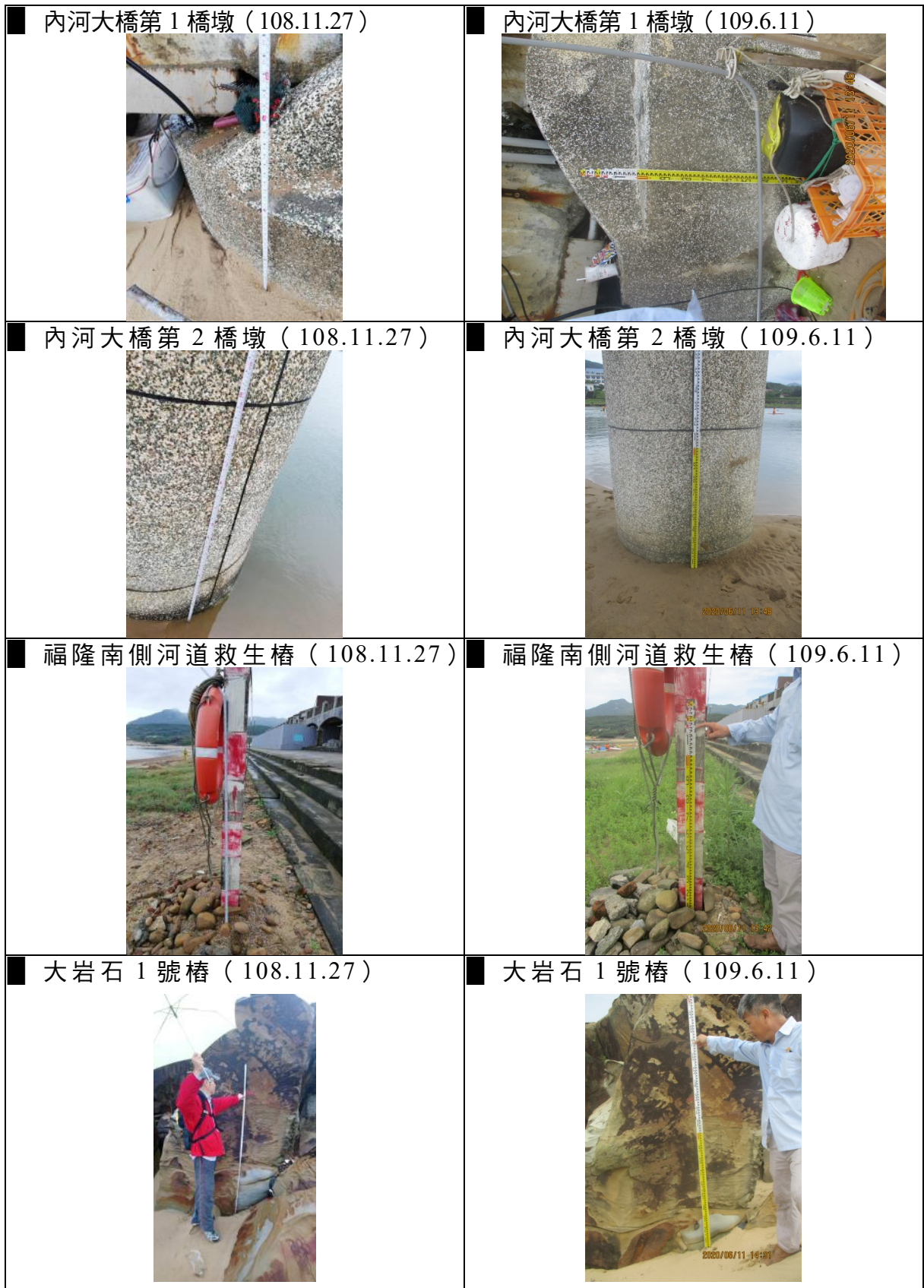
照片 2.5-1 核四封存期間定位樁觀測情形
