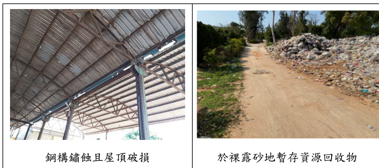
圖 1-3 環保設施常見的損壞狀況
