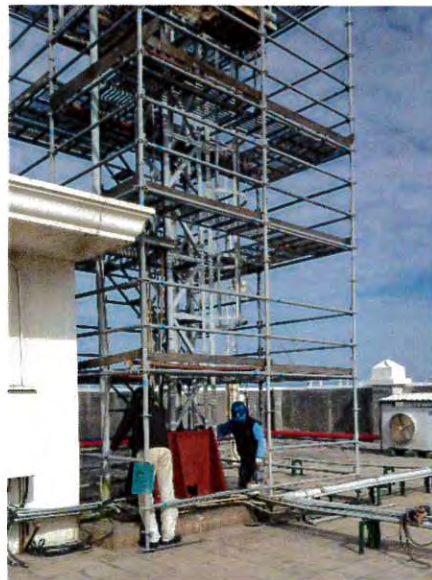
圖 1.2 逸散氣體監測行政大樓採樣點油漆粉刷作業施工圖
