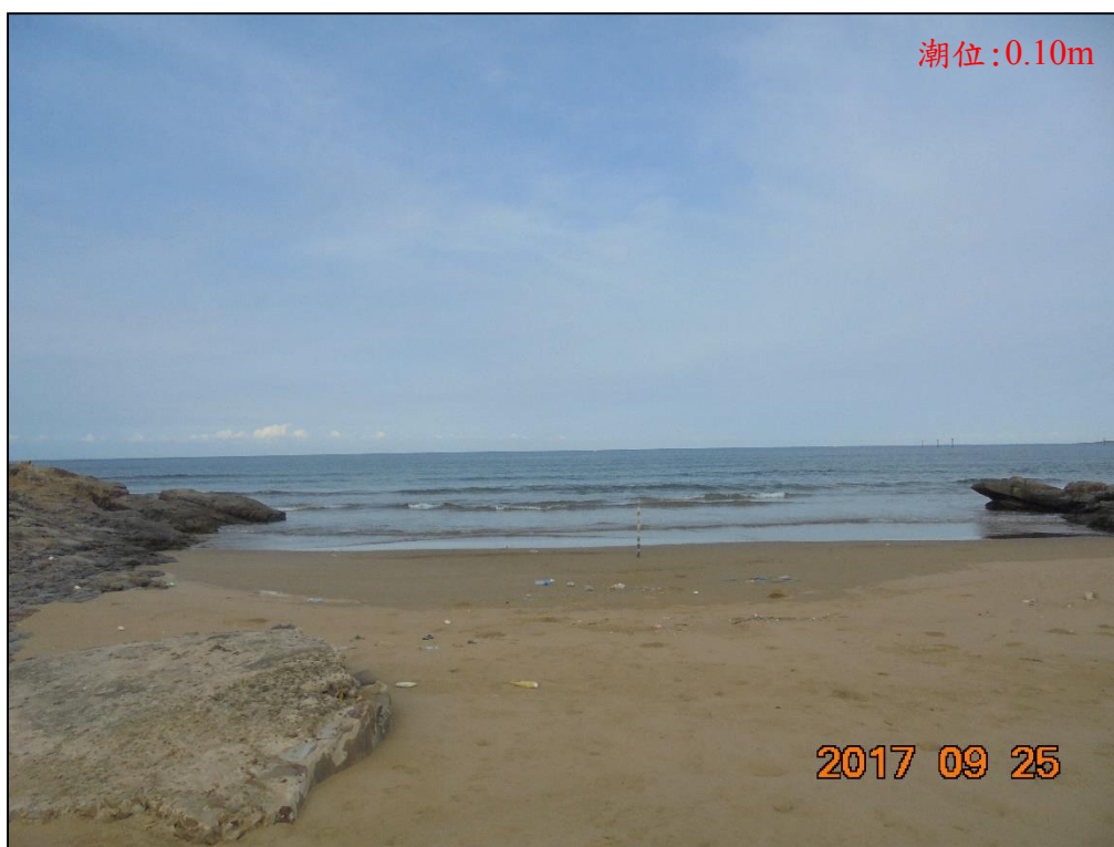
圖 4-12a 監測區南側大岩礁（黑石仔）後方碇堡（2017/9/25）
